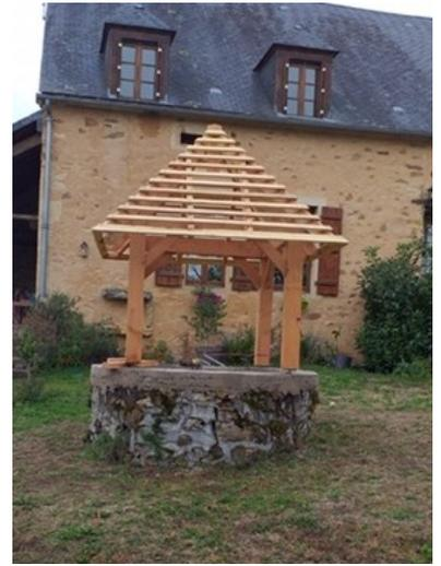
Rénovation du puit, coulage de la semelle et création de la charpente.
